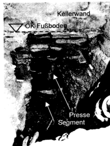
Bild 14: Abteufen eines Segmentpfahles
