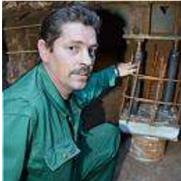
Unter dem Fundament präsentierte Franz-Josef Kihn von der Baesweiler Firma ErkaPfahl einen der 34 Presspfähle. (Bild: Pesch)
