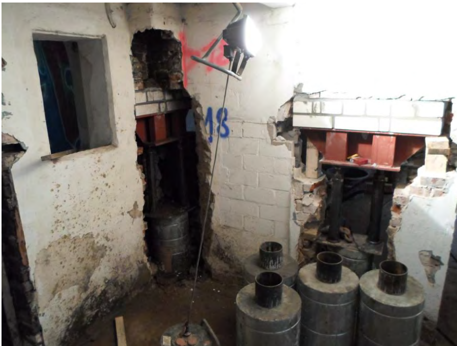
Pfahl Nr. 13 im Keller des Sahlhaus-Baus in der Hein-Hoyer-Straße auf St. Pauli. Die ERKA-Segmentpfähle wurden mittels Kernbohrung durch die Fundamente in den Baugrund gepresst und nach oben im Mauerwerk abgefangen. Im Bild gut erkennbar die Hydraulik-Pressen, mit der die einzelnen Segmente erschütterungsarm in den Untergrund gepresst werden.
