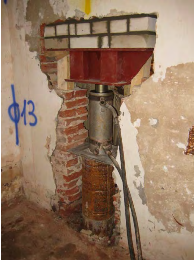
Pfahl Nr. 13 im Keller des Sahlhaus-Baus in der Hein-Hoyer-Straße auf St. Pauli. Die ERKA-Segmentpfähle wurden mittels Kernbohrung durch die Fundamente in den Baugrund gepresst und nach oben im Mauerwerk abgefangen. Im Bild gut erkennbar die Hydraulik-Pressen, mit der die einzelnen Segmente erschütterungsarm in den Untergrund gepresst werden.
