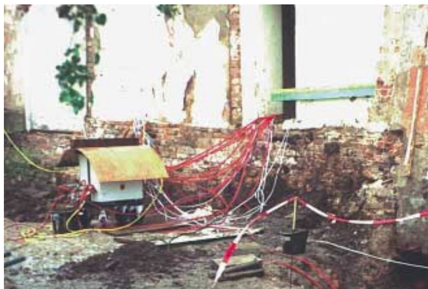
5 Hydraulikverteilerstation mit Anschlussleitungen für eine Bauwerkshebung (Fotos 3 bis 5: Erka Pfahl GmbH)
