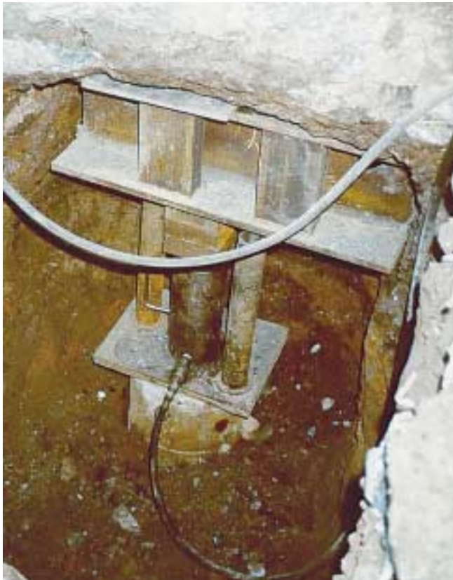
3 Kopfkonstruktion eines Segmentpfahles
