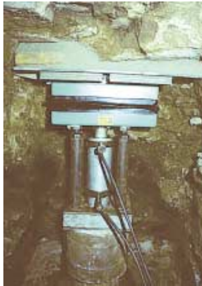
6 Feder-Pfahl-Kombination (Foto: Gerb GmbH, Erka Pfahl GmbH)
